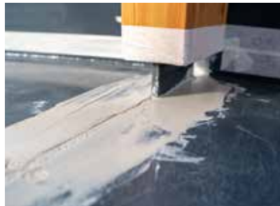
Zum Egalisieren der 5 mm tiefen Fuge verwendeten die Verarbeiter den flexiblen und schnellhärtenden Spachtel Wecryl 810.
