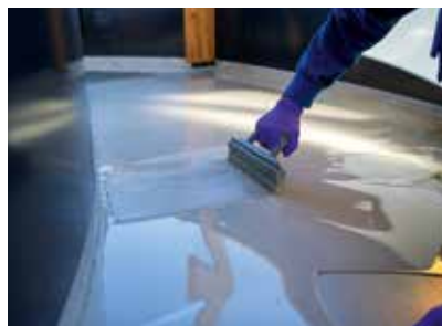
Nach kurzer Aushärtszeit (ca. 45 Minuten) wurde die zweite Lage der Abdichtung Wecryl 279 ebenfalls mit einem 6 mm Zahn-gummirakel aufgetragen.
