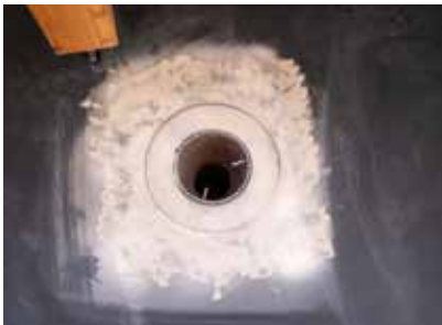
Der Stahluntergrund wurde mit 60er Schleifpapier sorgfältig und vollflächig angeschliffen.
