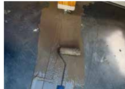
Anschließend kam auf die mit Wecryl 810 vorbereiteten Fugen die Detailabdichtung aus Wecryl R 230 mit Vlieseinlage und zweiter Schicht Wecryl R 230 (frisch in frisch).
