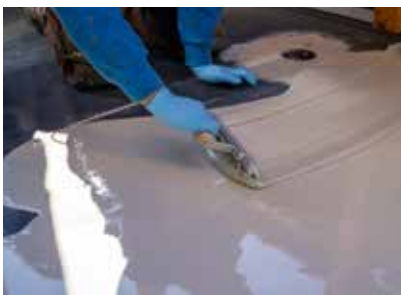
Auf die Fläche wurde die erste Lage der Abdichtung Wecryl 279 appliziert. Ein Haftvermittler war nicht notwendig, da Wecryl 279 ohne Grundierung ein Haftvermögen von > 3 N/mm 2 aufweist.
