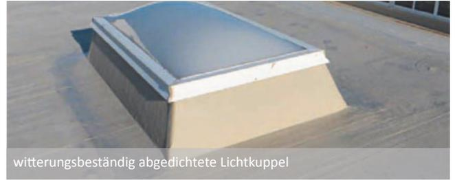
witterungsbeständig abgedichtete Lichtkuppel
