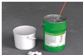
1. Abdichtungsharz vorgängig im Eimer gründlich aufrühren
