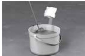
3. Katalysator (laut Mischtablelle, Temperatur- und Verarbeitungszeit) bei langsam laufendem Rührwerk zugeben und mind. 2 Min. (bitte die jeweilige Produktinformation in diesem Handbuch beachten!) mischen. (Kleinmengen können auch von Hand gemischt werden)
