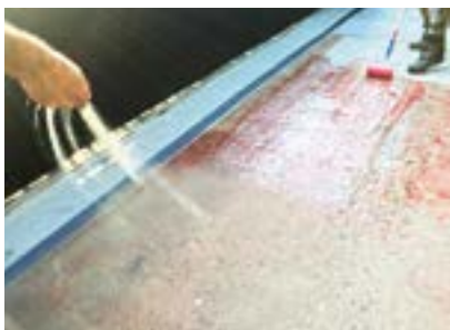
Die Teilfläche mit einer Rautiefe von < 1,5 mm erhielt die niedrigviskose Grundierung Wecryl 123 mit Quarzsand-Abstreung.
