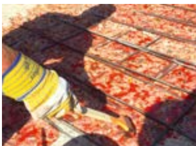
Der Betonuntergrund wurde mit dem Wecryl 123 Primer bis zur Sättigung grundiert.
