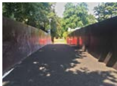
Durch Einsatz der PMMA-Systemkomponenten konnte nach drei Tagen Sperrzeit die Brücke wieder freigegeben werden.
