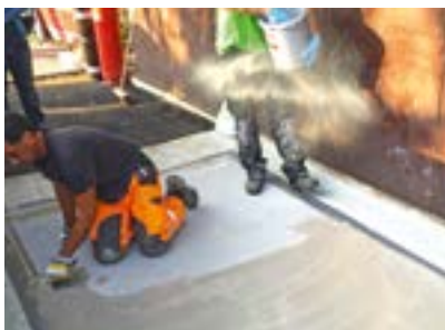
Auf den Betonflächen mit einer Rautiefe von > 1,5 mm wurde der Wecryl 123 Kratzspachtel aufgebracht und ebenfalls mit Quarzsand abgestreut.
