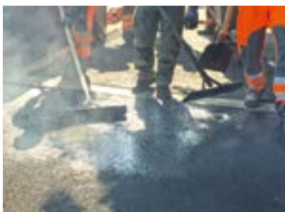
Somit vollzog sich auch der zügige Einbau des Gussasphalts einwandfrei.
