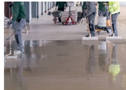
Auf die gehärtete hw0 des OS 10 trugen die Verarbeiter den Verlaufmörtel Wecryl 233 gleichmäßig auf.
