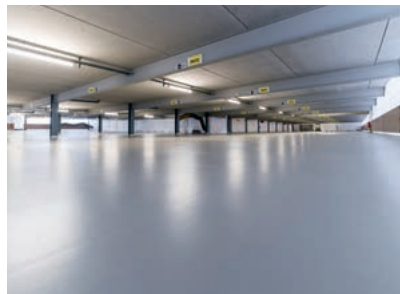
Um die erforderliche Schichtstärke sicher zu erreichen, wurde die hw0 in zwei Arbeitsgängen aufgetragen.
