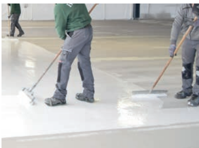
Nachdem der Untergrund geschliffen war, wurde die Grundierung Wecryl 123 vollflächig aufgetragen.
