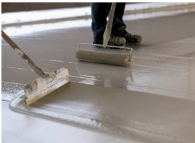
Die hw0 realisierten die Verarbeiter in der Fläche ohne Vlies: Wecryl 273 wurde per Zahngummirakel aufgezogen und mit dem Stachelroller abgerollt.
