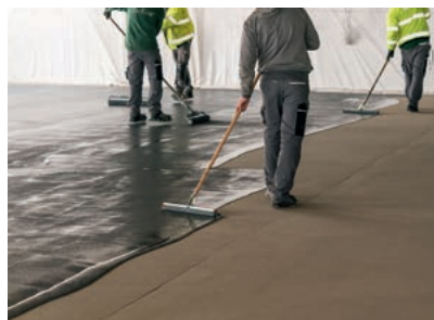
Mit der pigmentierten Versiegelung Wecryl 288 ließ sich die Oberfläche nach den individuellen Wünschen des Bauherren farblich gestalten.
