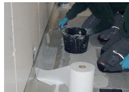
Die Abdichtung der Details erfolgte vliesarmiert mit Wecryl R 230 thix: das Harz wurde vorgelegt, das Vlies eingearbeitet und mit Harz gesättigt.
