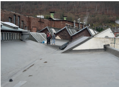
In Hagen stand eine Industriedach-Sanierung an, da unter dem Dach ein neuer Eventraum mit Lichtkuppeln eingerichtet wurde.
