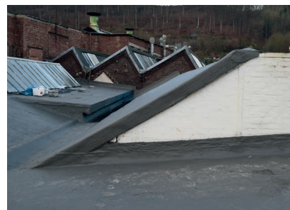
Das Sheddach und selbst komplexe Details konnten wasserfest abgedichtet werden.
