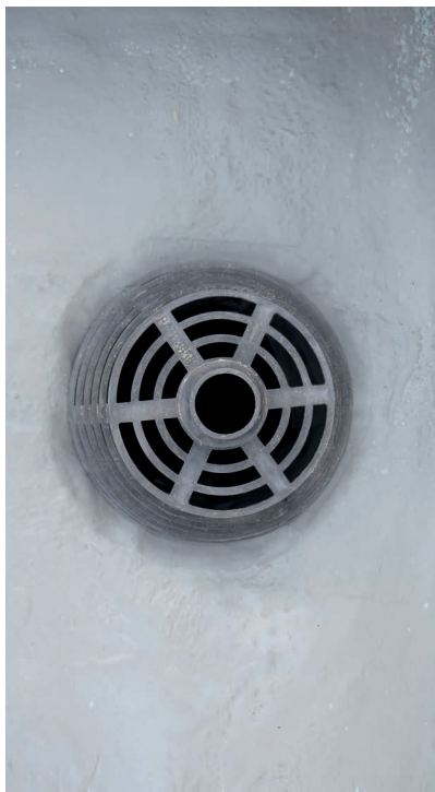
Die Detailabdichtung der freigelegten Gullys erfolgte mit dem PMMA-Abdichtungsharz Wecryl R 230.
