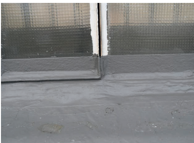
Auch auf wechselnden Untergründen ließen sich sämtliche Detailanschlüsse sicher in die Abdichtung einbinden.
