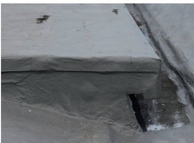
Die eingesetzten PMMA-Produkte Wecryl R 230 thix und Wecryl R 230 wurden in der Wunschfarbe RAL 7043 aufgebracht.
