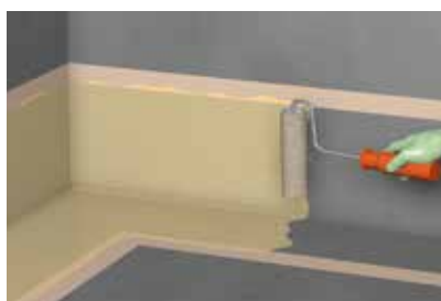
2. Falls nötig Applikation der Grundierung (siehe Untergrundtabelle)
