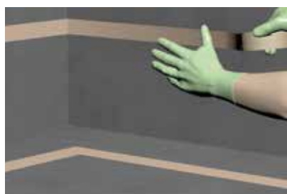
1. Untergrundvorbereitung und Abkleben der Abdichtungsfläche.
