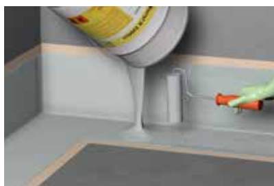
5. Nächster Auftrag von Wecryl 230 thix nass in nass.
