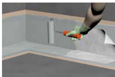
4. Einarbeitung des Vlieszuschnittes.
